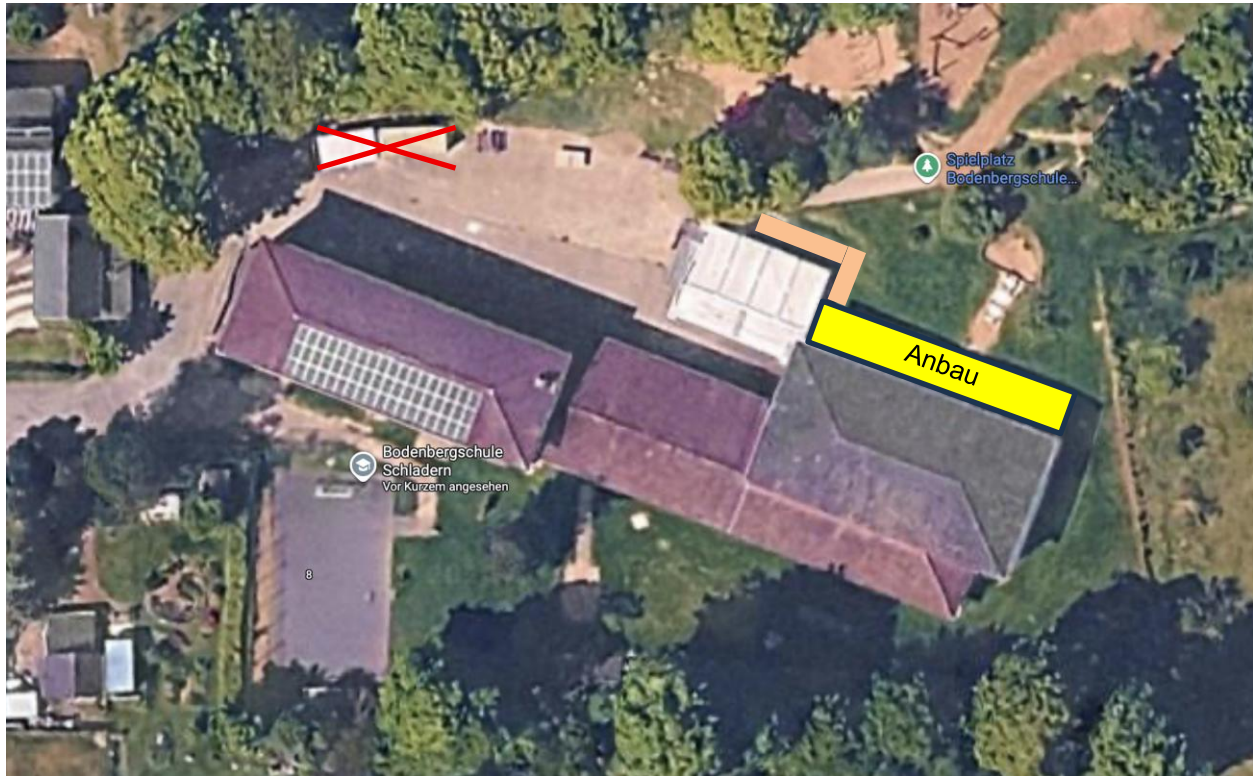
Abbildung 1: Luftbild der Bodenbergschule mit möglichen Anbauten und Entfall bisheriger Lagerflächen.
