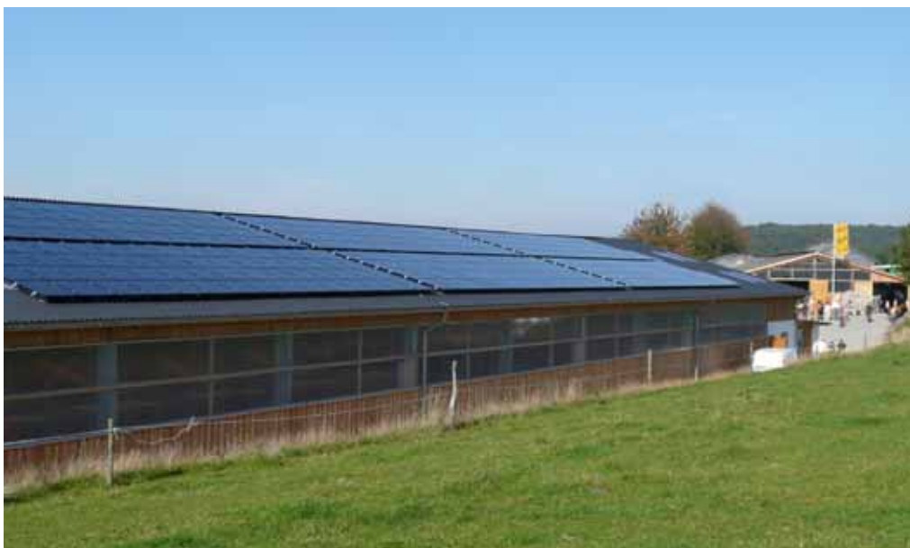
Eine Reithalle mit auf dem Dach montierter Photovoltaik-Anlage
