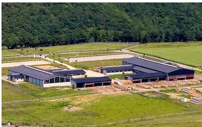
Die zentrale Reit- und Versorgungsanlage in Lonnig
